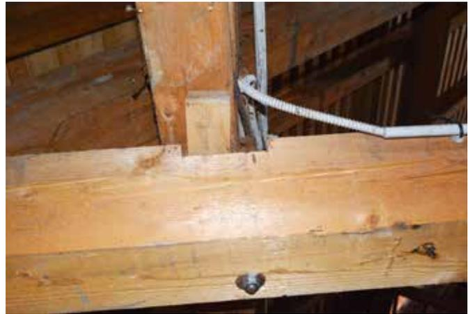
Durch die Verschiebung des Dachstuhls nach außen wurde der Querbalken aus der Kerne des durchgehenden Bundtrames gehoben
