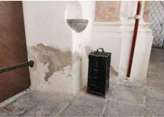
Basamento della parte longitudinale del fabbricato: sono ben visibili i danni da risalita di umidità già in stadio avanzato
