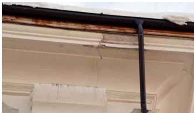
Fessurazione e infiltrazione d'acqua sul cornicione
