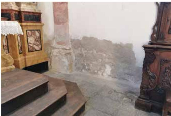
Sockelbereich im Langhaus: gut ersichtlich sind die bereits fortgeschrittenen Schäden durch die aufsteigende Feuchtigkeit
